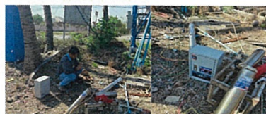
นำทีมช่างเข้าช่วยเหลืองานซ่อมไฟฟ้า และเปลี่ยนปั้มน้ำซับเมอร์สประปาหมู่บ้าน หมู่ที่ 3 ต.เขาวง
